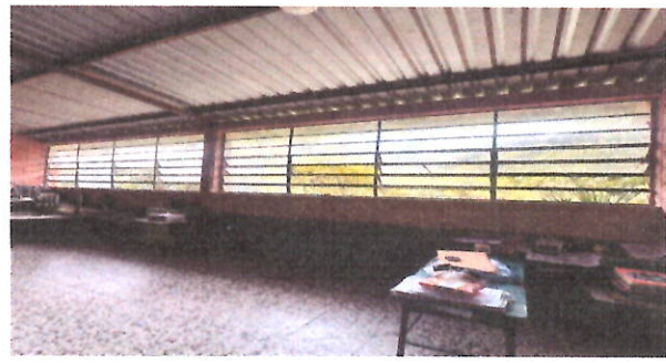
FOTO2:VENTANAS Sustrucción de ventanas; sistema de apertura: Corredizas, Perfiles color blanco estandar, Material del marco. PVC Material de la ventana. Vidrio, sellado perimetral.
