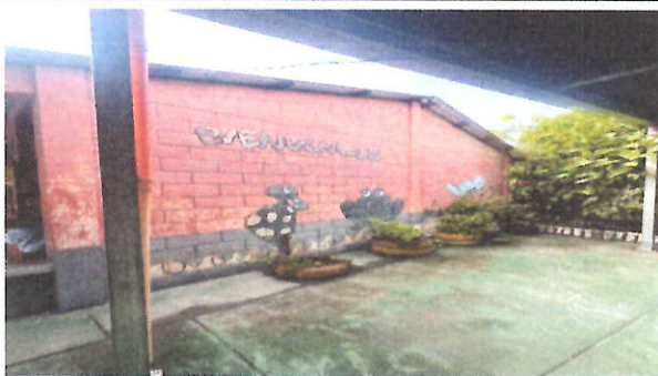
FOTO3:PINTURA EN MUROS INTERIOR Y EXTERIOR Preparación de la superficie y aplicación de pintura a dos manos, en paredes interiores y exteriores del establecimiento.
