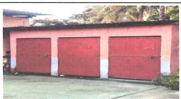
FOTO6:PUERTAS Mantenimiento a puerta metálica existente retiro de óxido, suciedad y pintura deteriorada, incluye cepillado, lijado y aplicación de pintura
