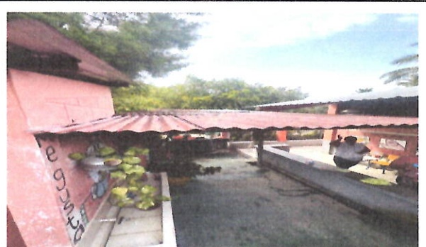
FOTO4:CUBIERTA DE LAMINA Sustrucción de cubierta de techo con lámina galvanizada, Tipo de lámina: troquelada Calibre: 26, incluye: fijaciones y sellado en traslapes.
