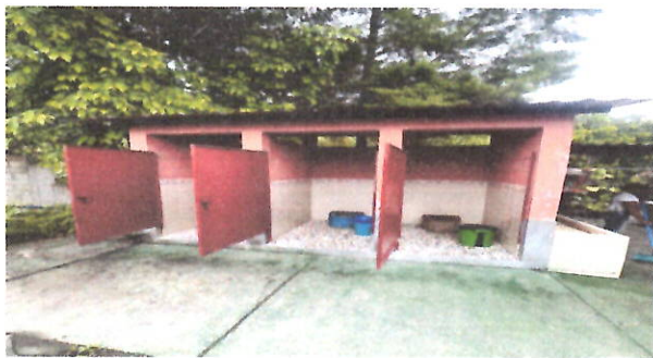
FOTO1:SERVICIOS SANITARIOS Y SUS ACCESORIOS Sustrucción de sanitarios lavables, accesorios y conexiones.
