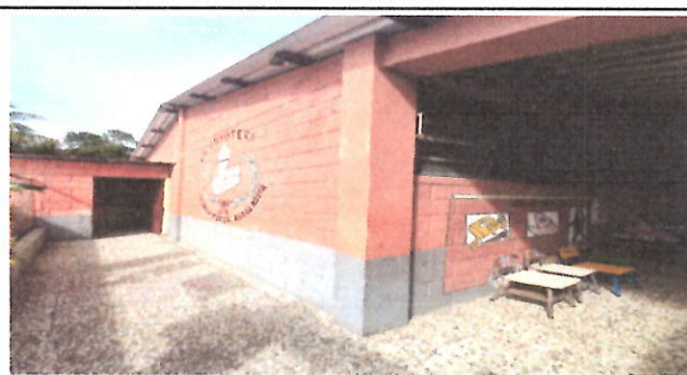
FOTO5:PINTURA EN MUROS INTERIOR Y EXTERIOR Preparación de la superficie y aplicación de pintura a dos manos, en paredes interiores y exteriores del establecimiento.
